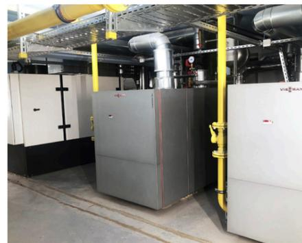
Absorptionskältemaschine zur Kälteerzeugung aus der Wärme des BHKW: Kälteleistung = 54 kW
